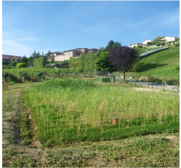
Figure 6. Dispositif de lits plantés de roseaux dans la région du Barolo en Italie.
